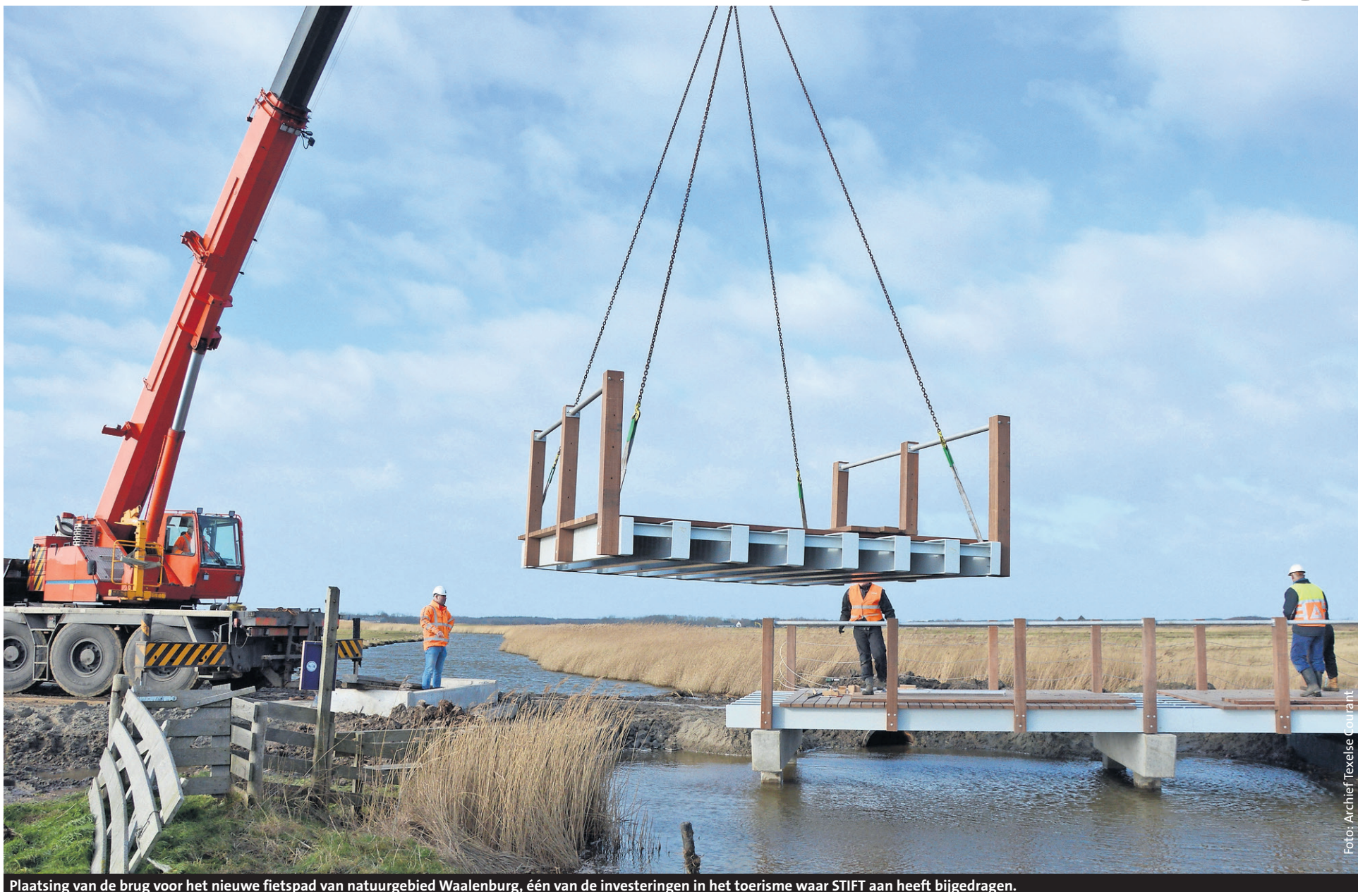
Plaatsing van de brug voor het nieuwe fietspad van natuurgebied Waalenburg, één van de investeringen in het toerisme waar STIFT aan heeft bijgedragen.
