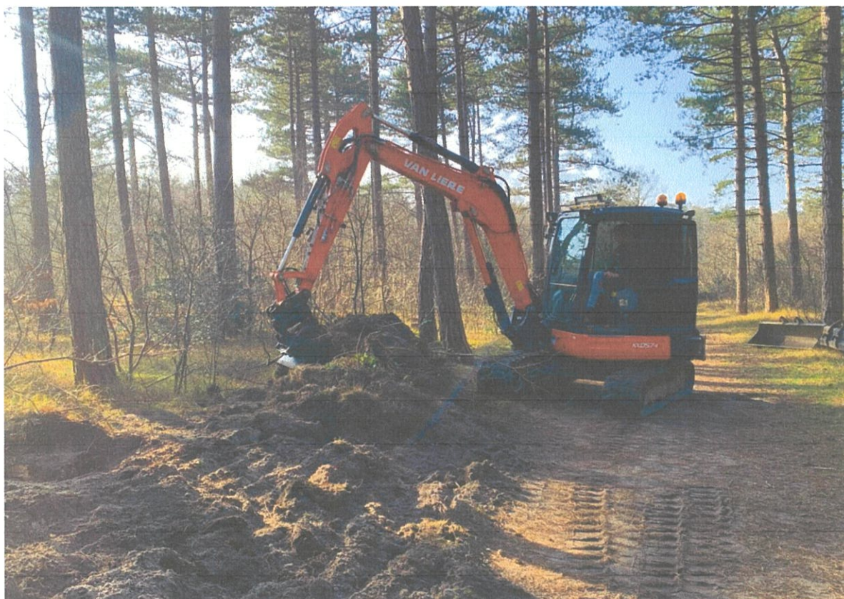
Aanleg Trimbaan in het bos
